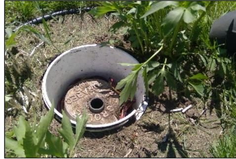
Puits artésien non conforme (trou dans le couvercle et ne dépasse pas du sol)
