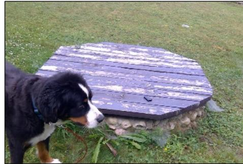
Puits de surface non conforme (couvercle en bois et dégagement inférieur à 30 cm )
