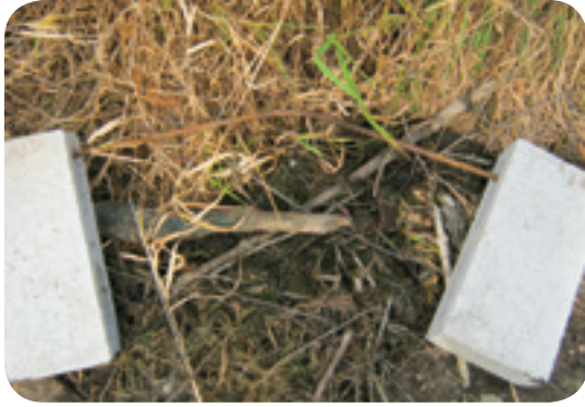
Figure 58 : Ancre formée d'une tige de métal et de blocs de ciment
