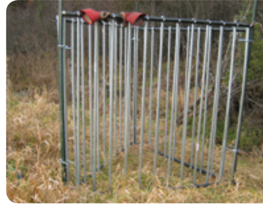
Figure 50 : Assemblage de la cage
