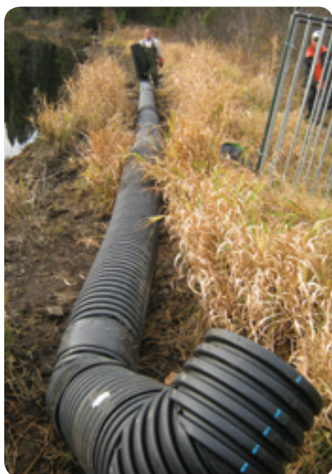
Figure 49 : Assemblage complet d'un système de drains
