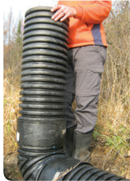
Figure 42 : Mise en place de la sortie d'eau
