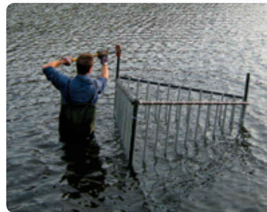
Figure 51 : Mise en place de la cage
