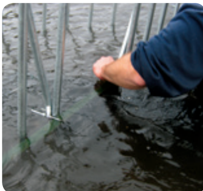
Figures 54 et 55 : Mise en place de la barre horizontale
