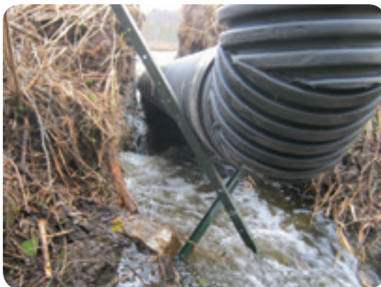
Figure 52 : Positionnement du drain à travers le barrage
