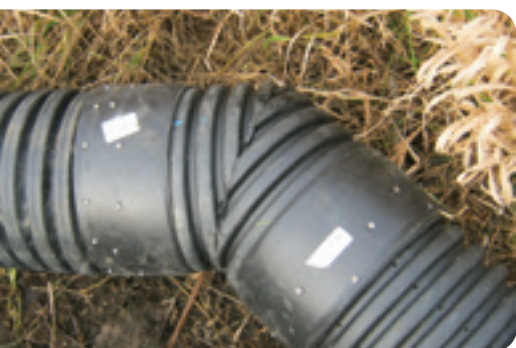
Figure 48 : Solidification du joint à 45°
