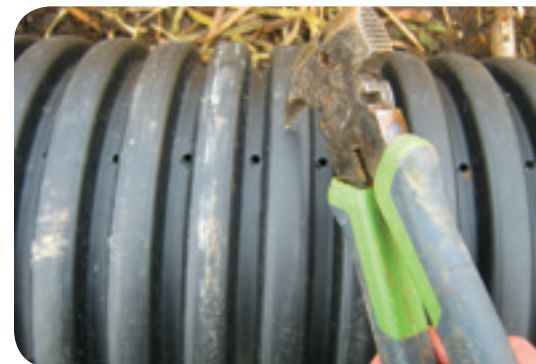
Figure 44 : Perforation des trappes à air
