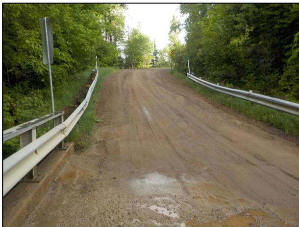
Photo 10 : Ruissellement de surface et apports de sédiments au cours d'eau, chemin des Loisirs à proximité du pont enjambant la rivière Yamachiche (site n° E08), Saint-Élie-de-Caxton.
