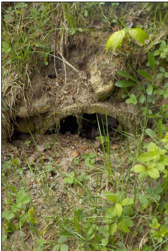
Photo 9 : Ponceau obstrué et non stabilisé à l'entrée et à la sortie (n° P15), Chemin 5<sup>e</sup> rang N, Saint-Élie-de-Caxton.
